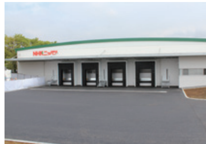
新設された群馬工場カバーリング新棟
