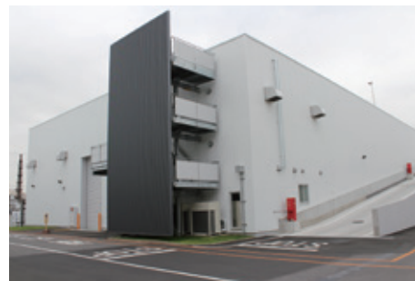
厚木工場の新プレス棟
