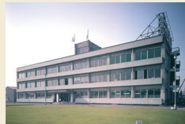
横浜工場 (磯子) に隣接して建設された新本社
