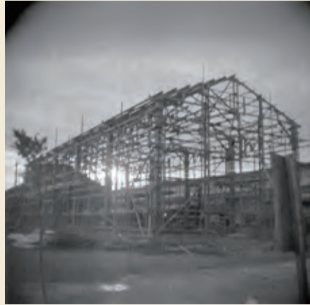
建設中の横浜工場（磯子）
