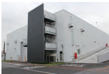
厚木工場の新プレス棟
