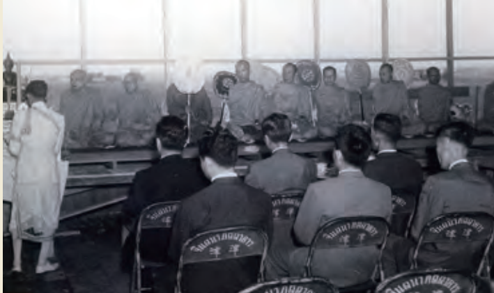
タイに初の海外進出。1963（昭和38）年8月30日に行われたタイニッパツの起工式
