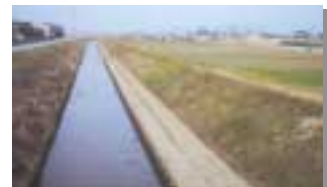
3月末に整備工事が完了
