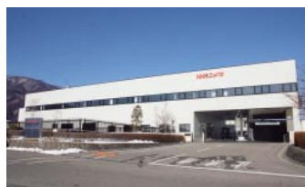
完成したDDS駒ヶ根の新事務所棟
