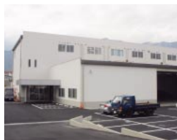
竣工した伊那第11工場
