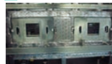
乾燥炉外周への断熱材貼付
