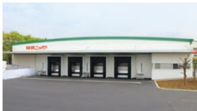
群馬工場カバーリング新棟
