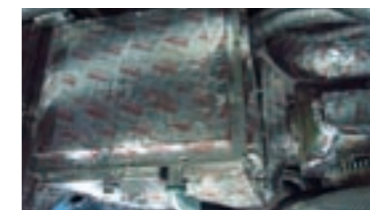
洗浄槽外周への断熱材貼付
