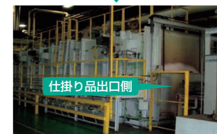
焼戻し炉出口側
