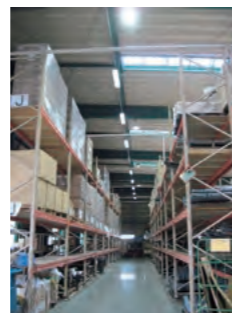
ニッパツ埼玉デポに設置された新型LED高天井器具
