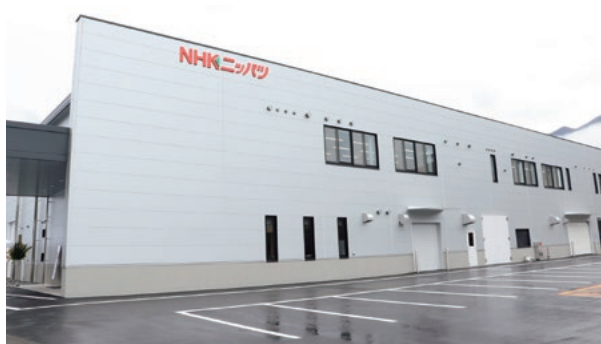
新設された伊那第二工場
