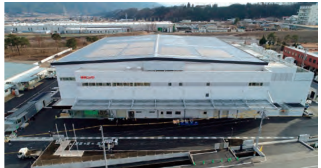
宮田工場(144kW)(2018年度稼動開始)
