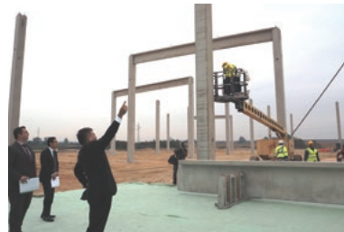
建設現場で行われた梁上式
