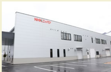
新設された伊那第二工場
