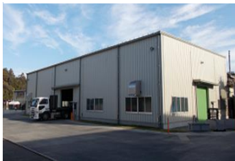
材料倉庫の新設
